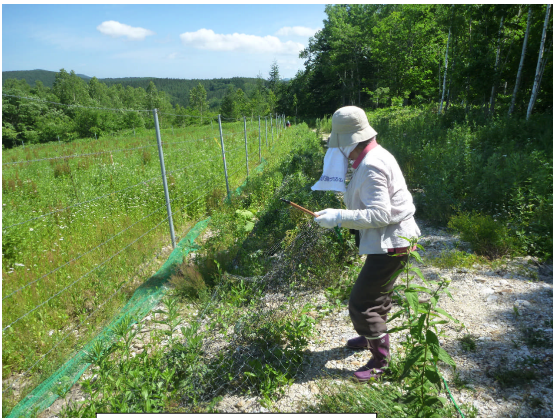
鹿ネット取り付け
